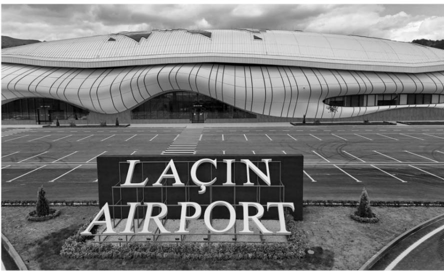
Hava limanında istənilən tip hava gəminin qəbuluna imkan verən, uzunluğu 3 min, eni isə 60 metr olan uçuş-enmə zolağı inşa edilib. Beş min kvadratmetrik terminal binası saatda ən azı 200 sərnişinə xidmət göstərmək imkanına malikdir. Terminalda sərnişinlərin rahatlığı üçün VIP zal, qeydiyyat və təhlükəsizlik sistemləri, baqaj konveyerləri, ticarət obyektləri və iaşə zonaları nə-
